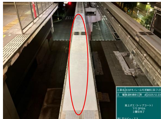
走行面の段差修正
