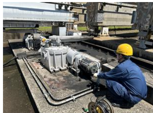
(信号通信課) 分岐器手動転換訓練
