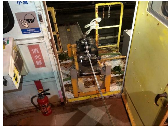
トロリー線張替作業
