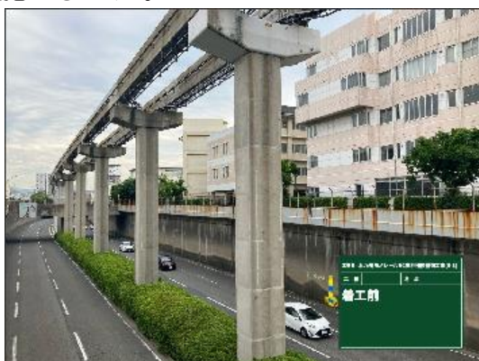
施工前（片野駅～城野駅間）
