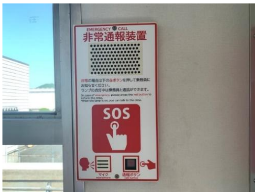
非常通報装置
