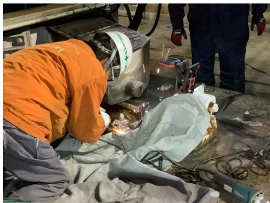
分岐桁ジャッキアップ作業
