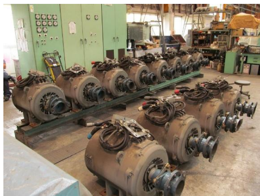
主電動機整備
