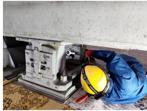
（施設課）支承部ボルト交換訓練
