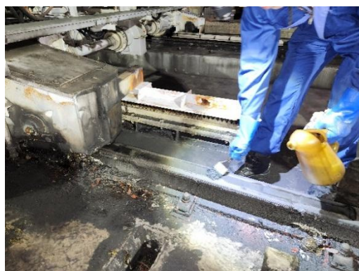
分岐器の点検
