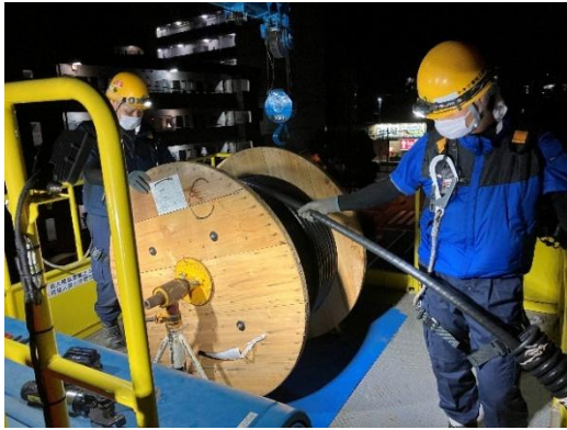
高配ケーブル張替作業
