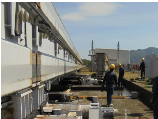
分岐器の点検・補修作業
