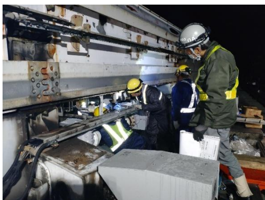
ギヤモーター取替作業
