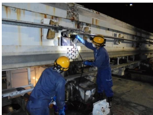
分岐器の点検
