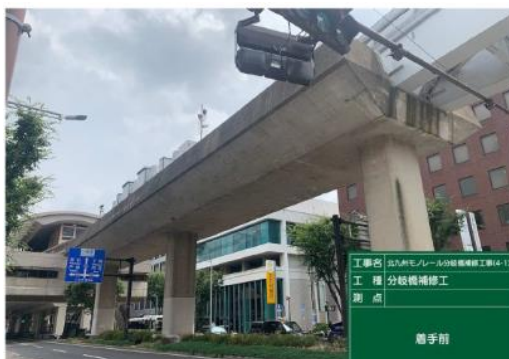
平和通分岐橋 施工前
