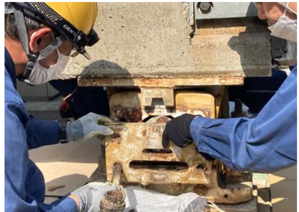
支承分解訓練
