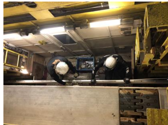
トロリー線（電車線）張替作業
