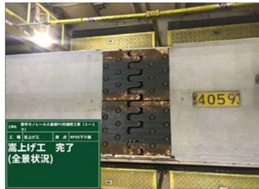
施工後(段差が解消されています)
