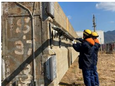
ウッドセクション補修
