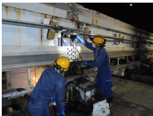
分岐器の点検
