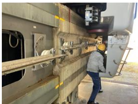
パンタグラフ補修
