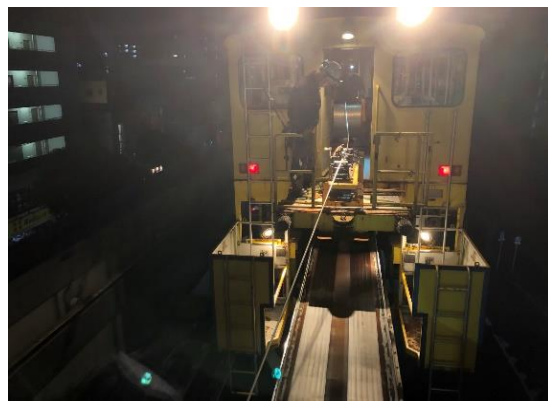
トロリー線（電車線）張替作業
