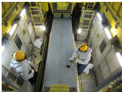
軌道走行面の点検
