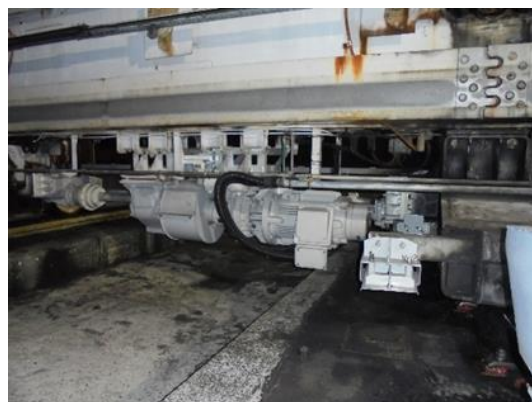
分岐器ギヤモーター更新
