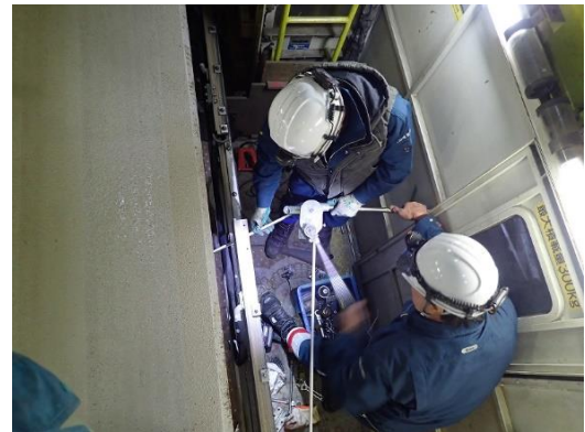
トロリー線（電車線）張替作業
