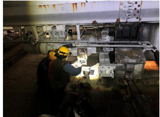
分岐器駆動装置取替
