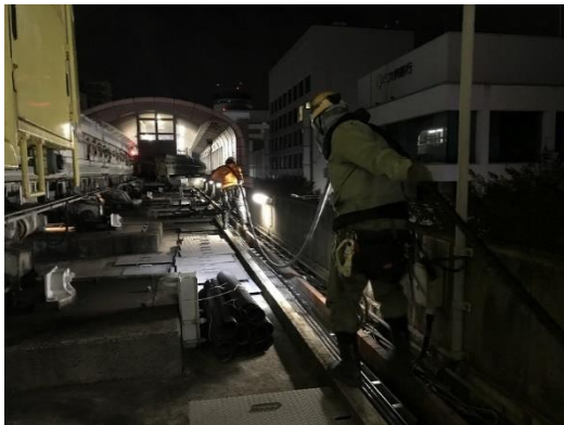
き電ケーブル張替作業
