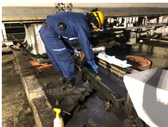
分岐器の点検
