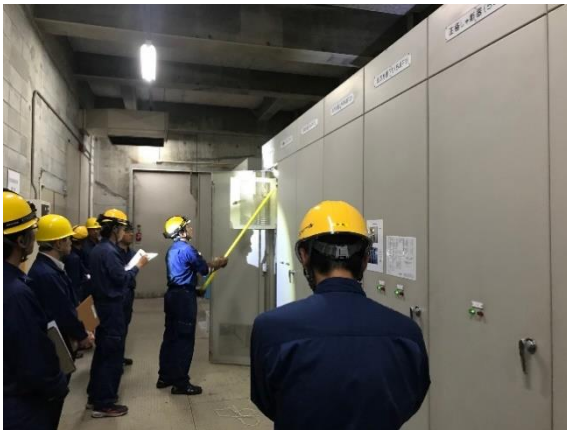
変電所連絡用断路器操作訓練
