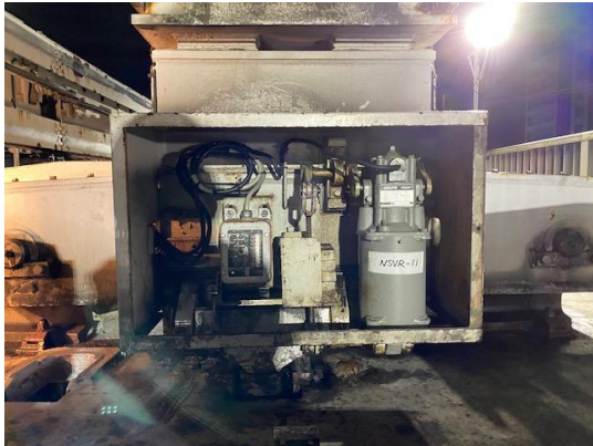
分岐器サーボリフター取替
