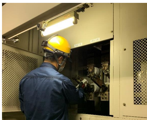
変電所設備の点検
