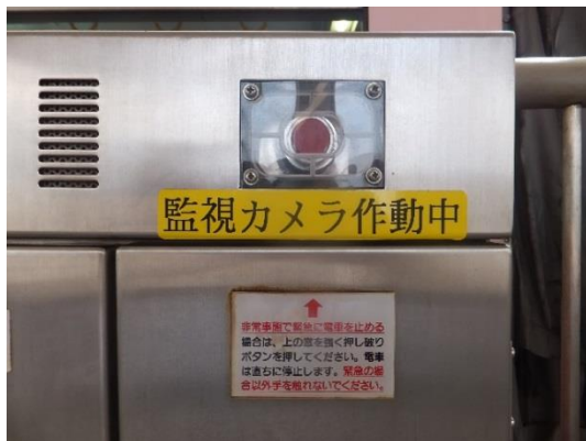
列車非常停止ボタン
