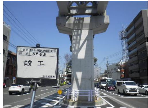
施工後(支柱が太くなっています)
