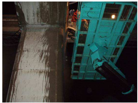
含侵材塗布作業2
