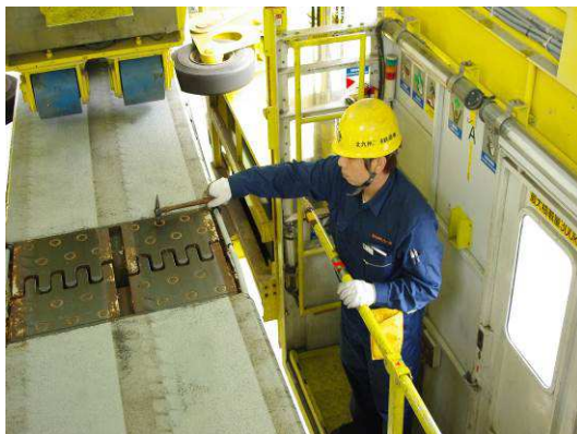
ボルト緩みの点検
