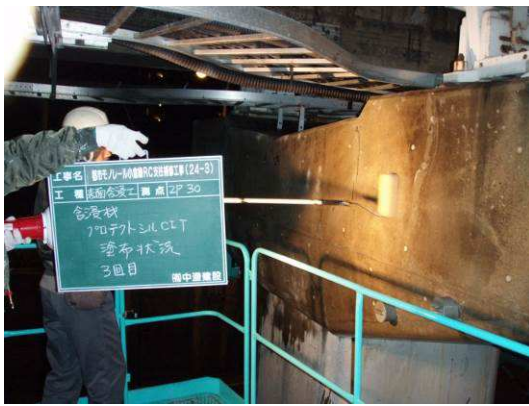
含侵材塗布作業 1
