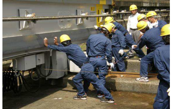
トラバーサ（可動桁）手動操作
