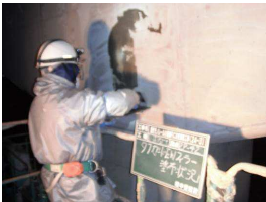
コンクリート面の下地処理状況
