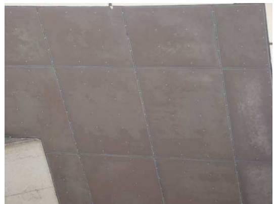
ビス止めによる補強
