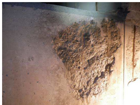
コンクリート表面の浮きを撤去
