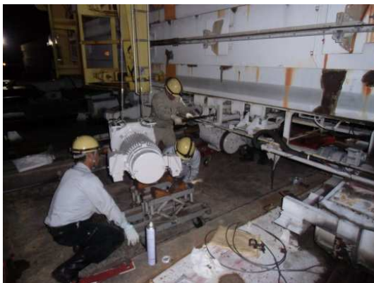
分岐器駆動装置取替
