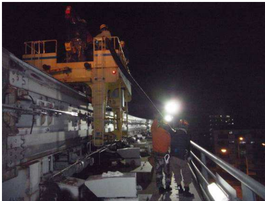
高配ケーブル張替
