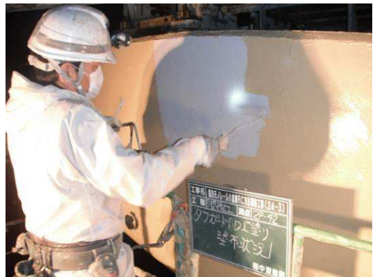
剥落防止最終仕上げ状況
