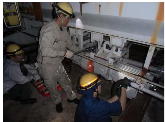
分岐器駆動装置取替
