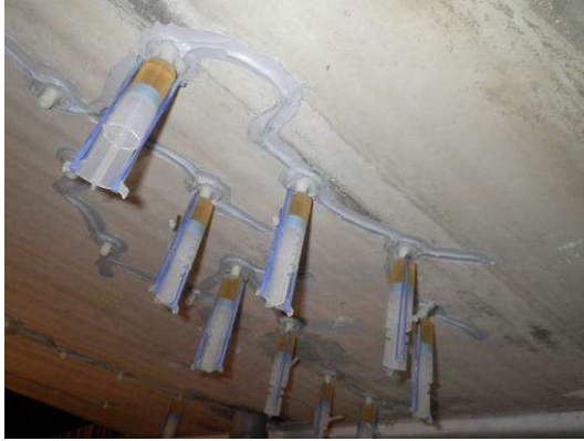
樹脂を注入するための注入器設置
