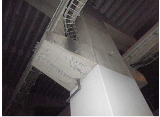
柱の下面の注入器設置状況
