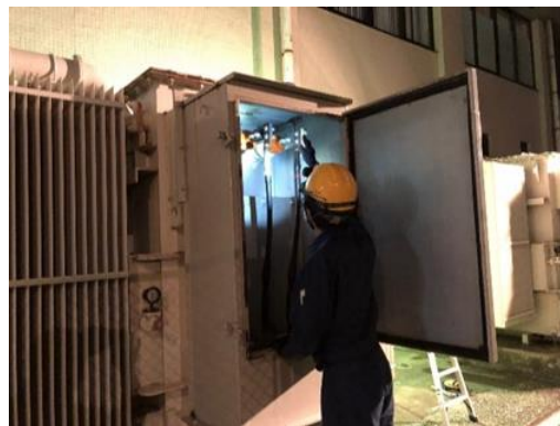
変電所設備の点検
