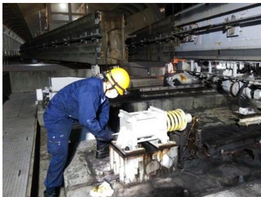
分岐器油圧緩衝器取替
