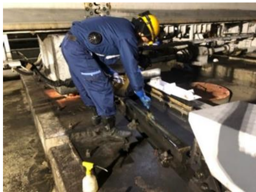
分岐器の点検
