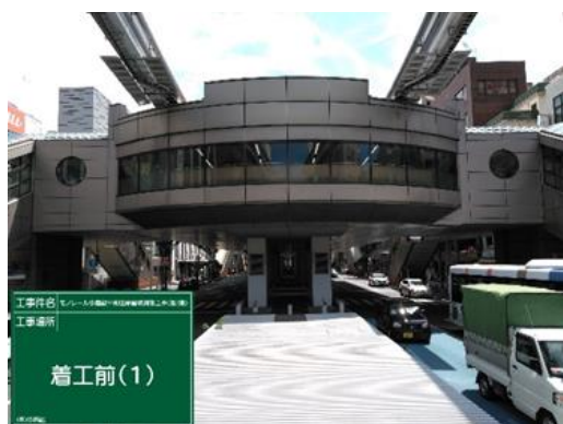
平和通駅北口 施工前
