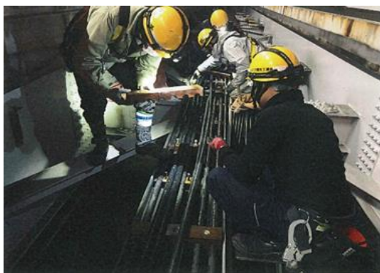
高配ケーブル張替作業
