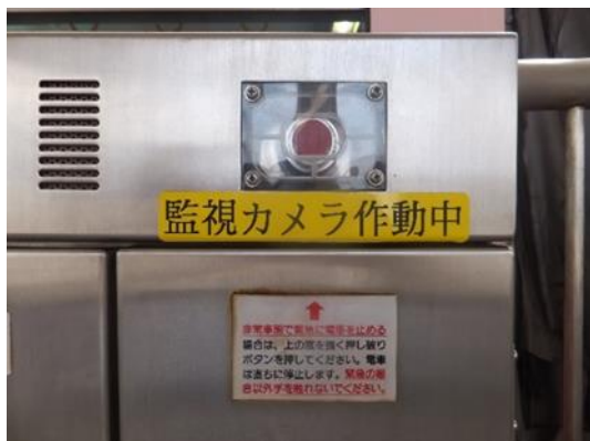
列車非常停止ボタン
