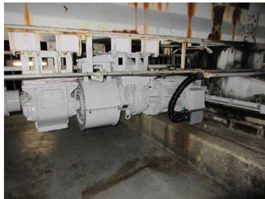
分岐器ギヤモーター更新
