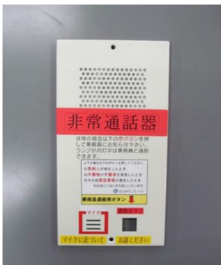
各客室に設置しています
