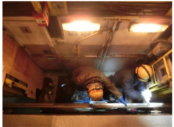
トロリー線（電車線）張替
