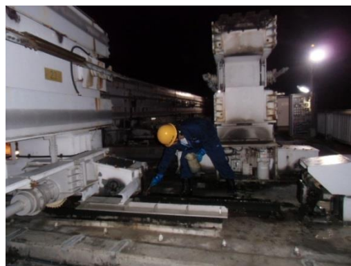
軌道設備の点検
