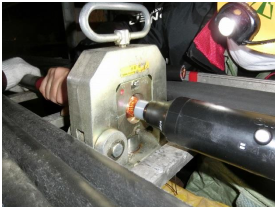
高圧ケーブル張替
