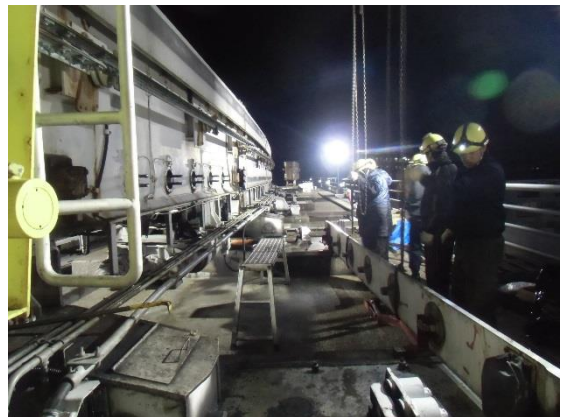
分岐器安定面補修
