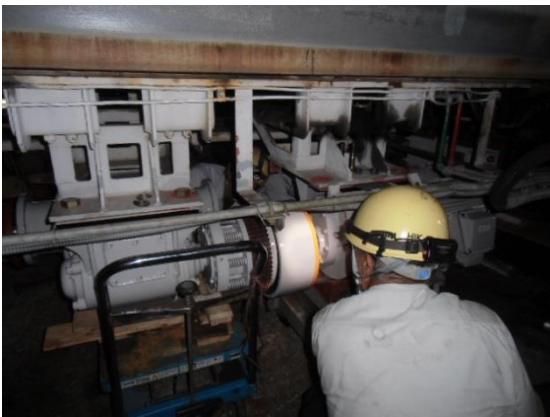
分岐器駆動装置取替
