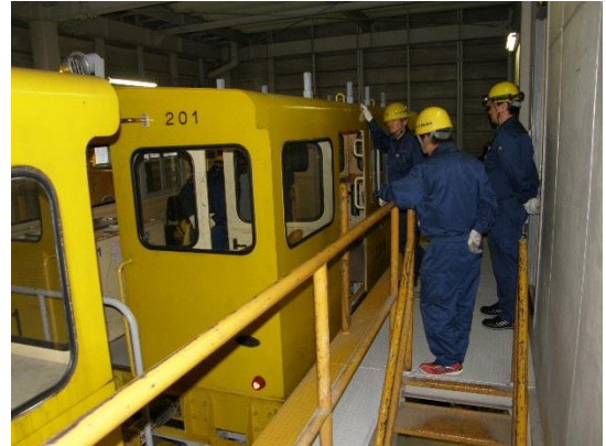
復旧作業完了及び報告
