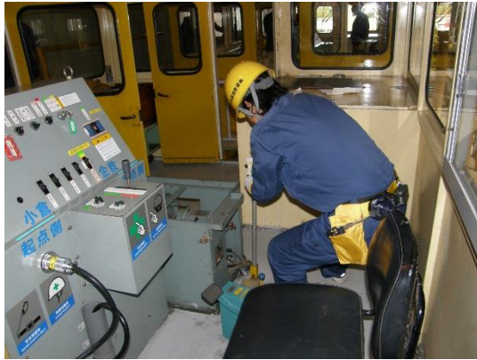
異常事態における復旧処置
