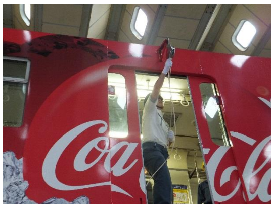
緩降機の取付け
