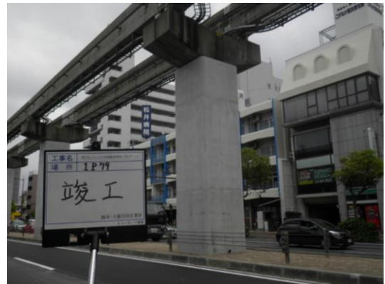
施工後(支柱が太くなっています)
